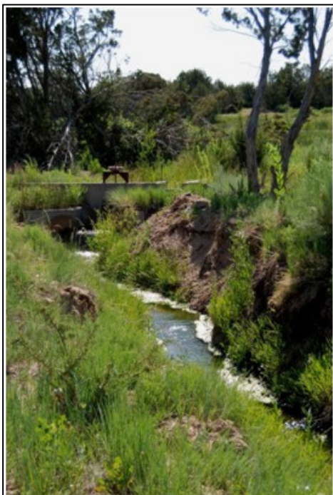
Acequia La Cienega Diversion Headgate
