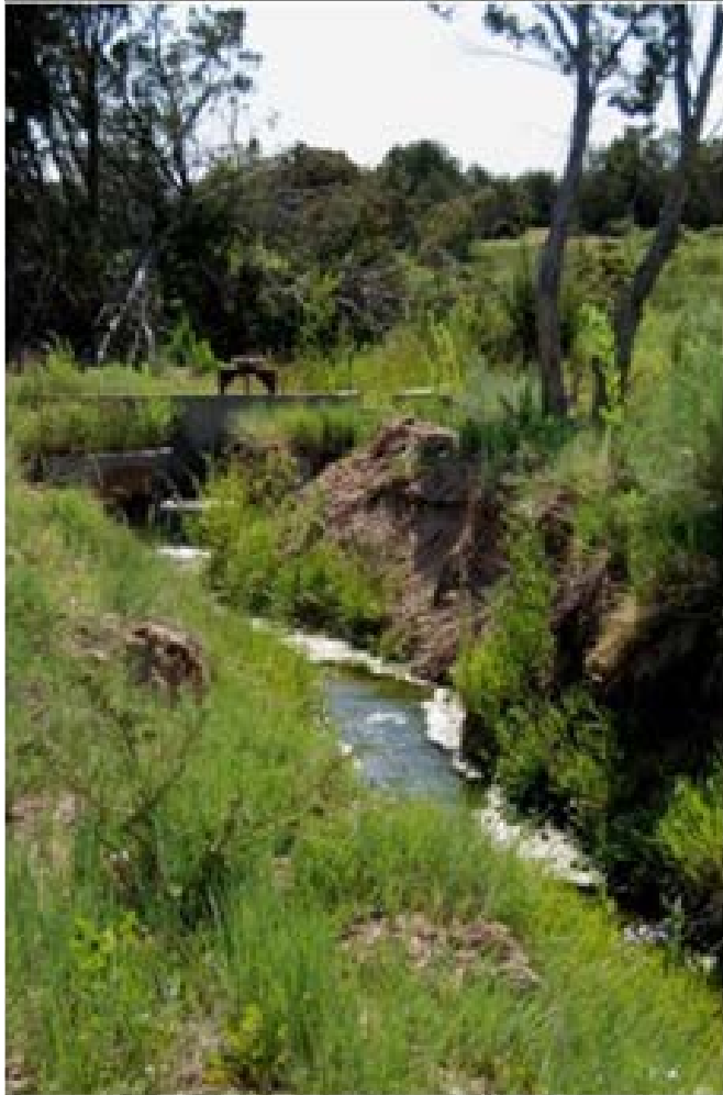
Acequia La Cienega Diversion Headgate
