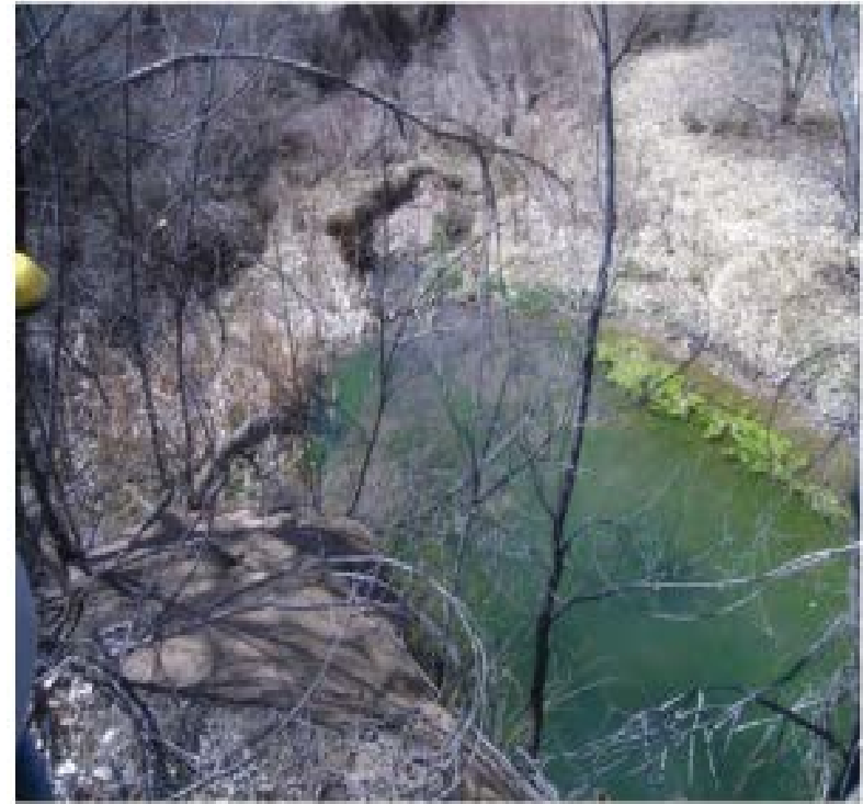
Acequia La Cienega Diversion Headgate
