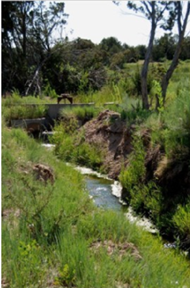
Acequia La Cienega Diversion Headgate
